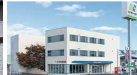
丸片機水工業本社社屋
